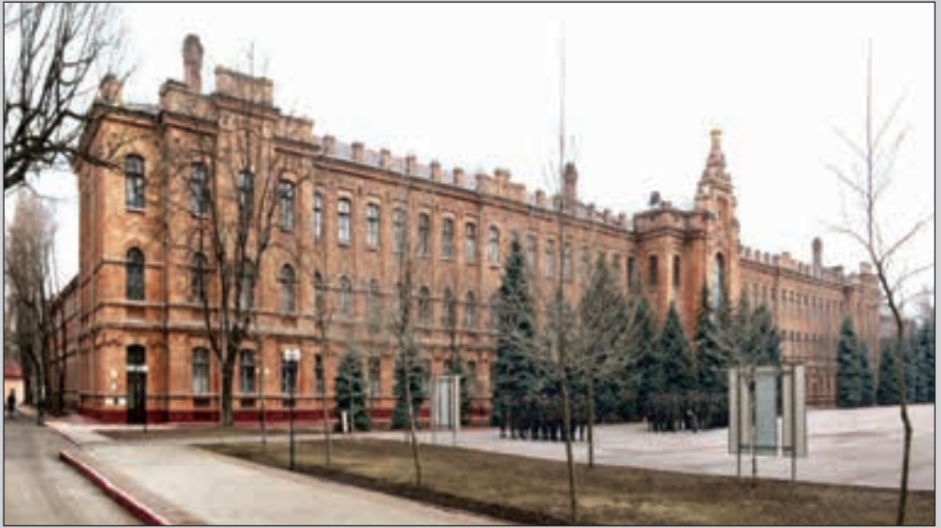
Одеський кадетський корпус. Споруджено 1827 р. як хлібні склади графа Ієроніма Собанського. Арх. Іван Козлов, Кастан Даллаква. Фотографія. Поч. ХХ ст.
