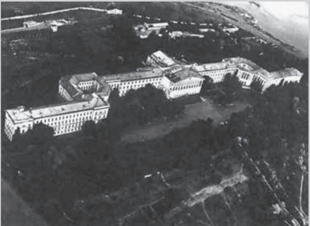
Севастопольський морський кадетський корпус. Арх. Олександр Венсан. Споруджено в 1915—1916 рр. Сучасний аерофотознімок
