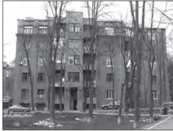
Будинок «Слово» в Харкові. Фото початку 21 ст.
