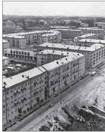
Чоколовка в Києві — житловий масив, забудований «хрущовками». Фото 1960.
