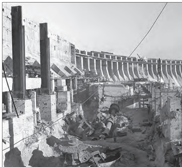
Зруйнований машинний зал Дніпрогесу. 1943.
