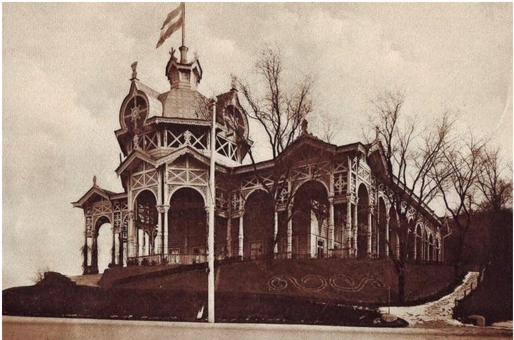
Київ, літнє приміщення купецького зібрання (фото В.Гудшона та О.Губчевського, 1912 р.)
